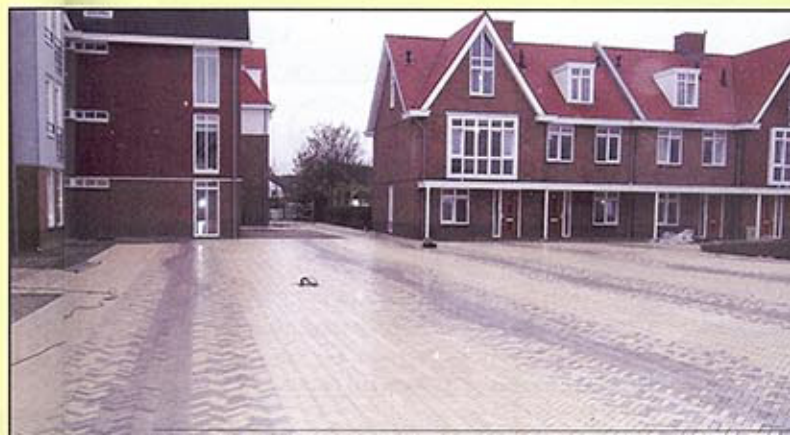
De waterpasserende verharding ligt volledig vlak.
